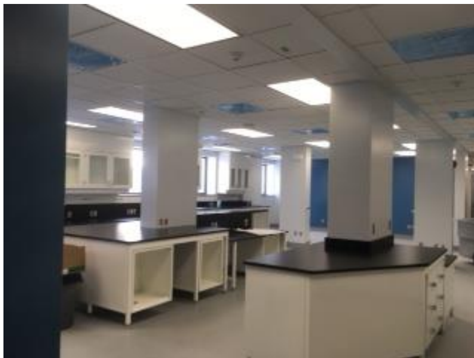
Un premier aperçu du laboratoire neuf de Montmagny. Les travaux de finition sont en cours.
