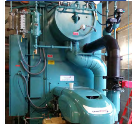
Bouilloire à vapeur à l'Hôtel-Dieu de Lévis
