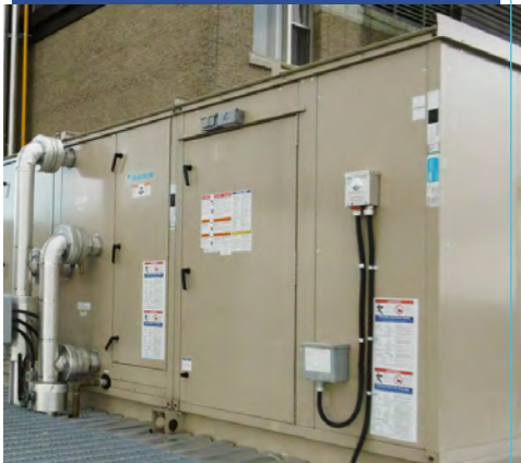
Aérothermie à l'Hôtel-Dieu de Lévis
